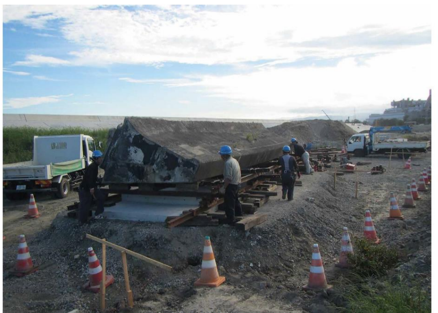
▲防災緑地内に設置される様子
