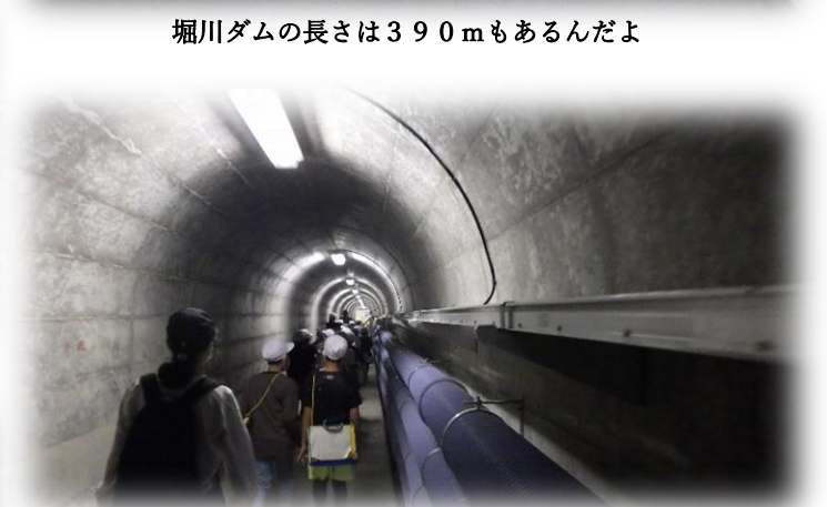
監査廊の中は年間を通して同じ温度なんだよ
