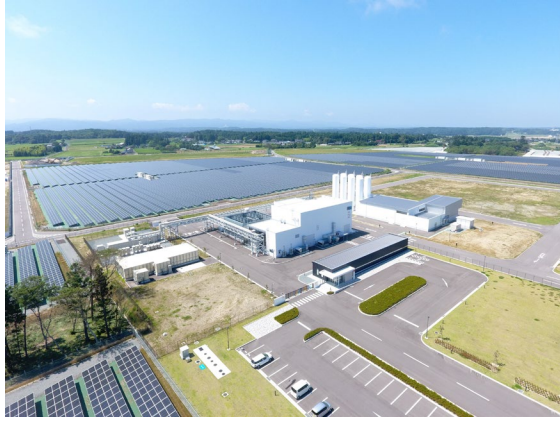
福島水素エネルギー研究フィールド（提供:NEDO）
