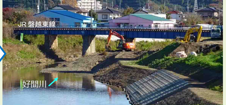
河道掘削状況【施工中】
