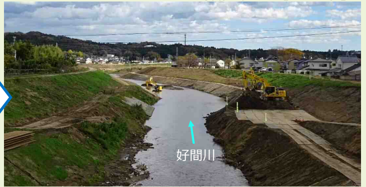
河道掘削状況【施工中】
