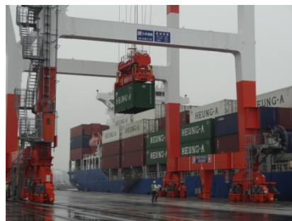
コンテナ荷降状況
