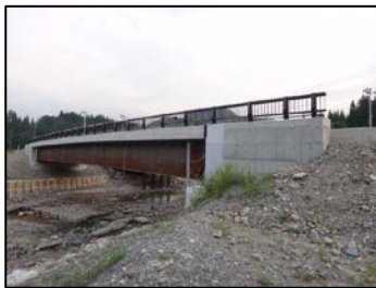
上部工架設後の様子
