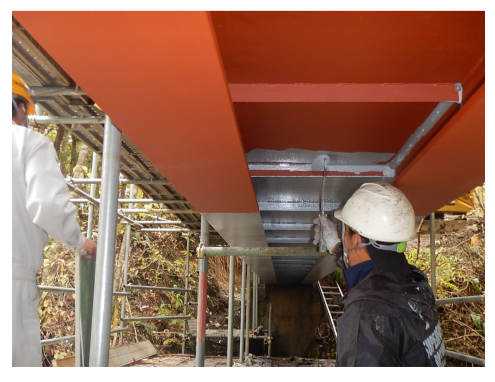
水無水路橋 (下塗り3回目作業状況)
