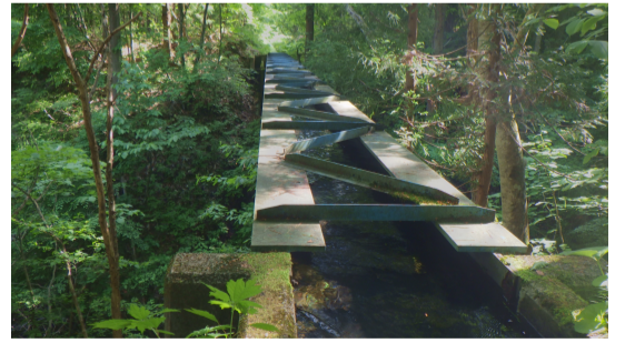
水無水路橋 (施工前の現況写真)
