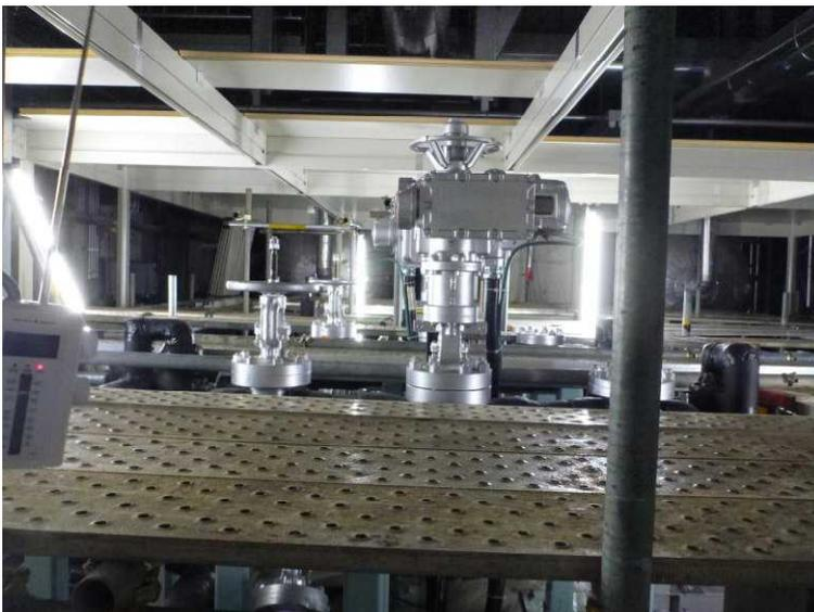
○炉注水ポンプ電動弁
