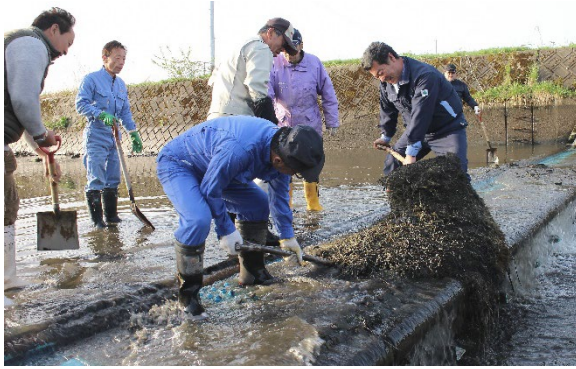
地域ぐるみでの堰の土砂上げ作業
