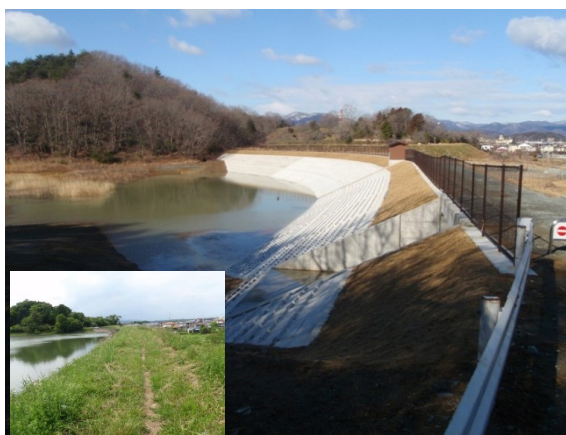
決壊による家屋等の被害を未然に防止する 老朽化したため池の改修(左下:施工前)
