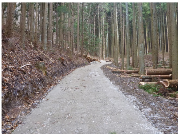
森林作業道の開設
