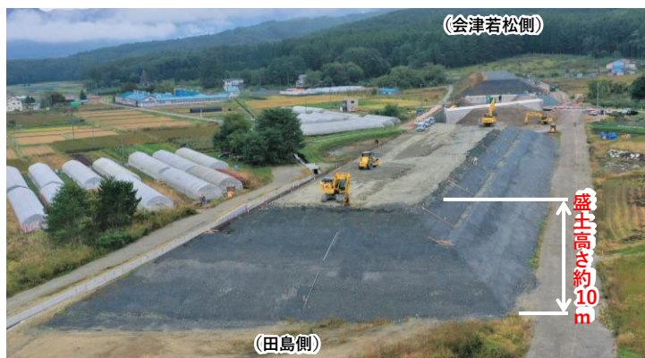
【工事状況写真① (R3.10.19)】
