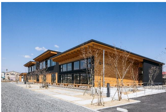
中大規模建築における県産材の利用 (郡山ヘアメイクカレッジ)
