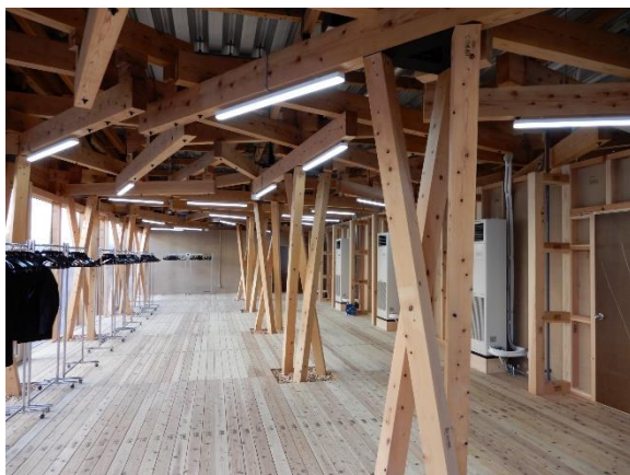
認証材を使用した施設(オリパラビレッジプラザ)
