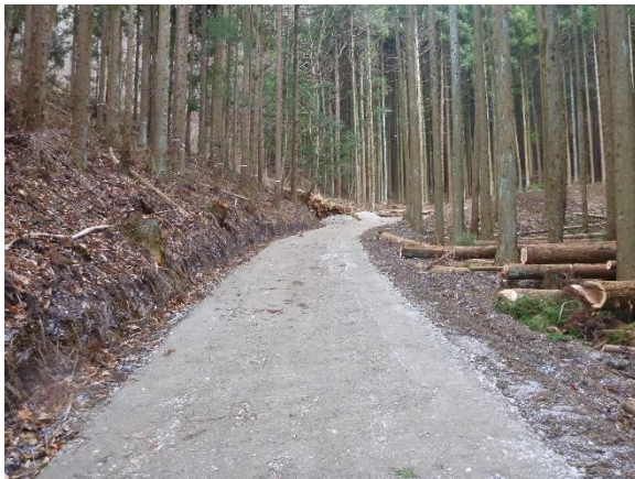
森林作業道の開設
