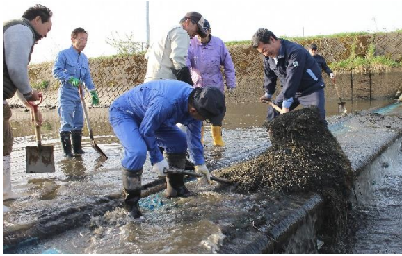
地域ぐるみでの堰の土砂上げ作業
