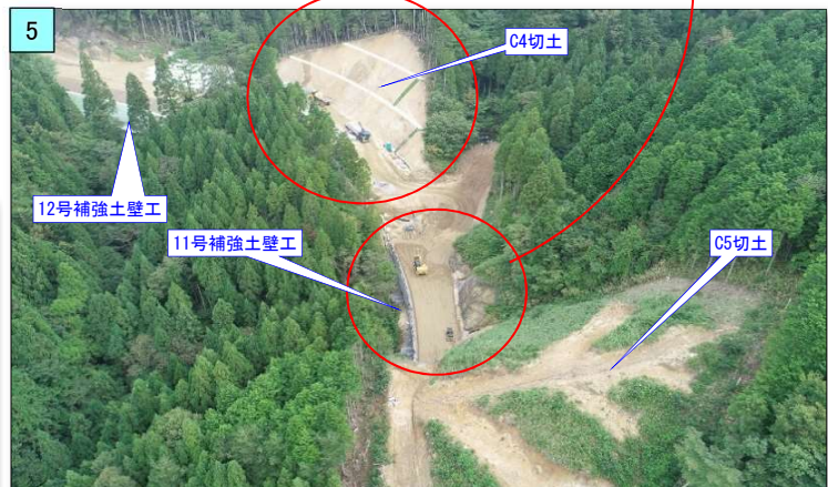
11号補強土壁や前後の切土法面の施工状況
