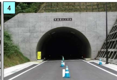
トンネル終点側坑口(川内村側)
