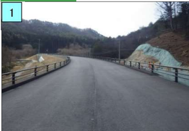
1工区の完成状況
