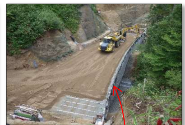
11号補強土壁の施工状況
