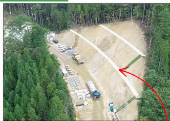
法面の切土施工状況
