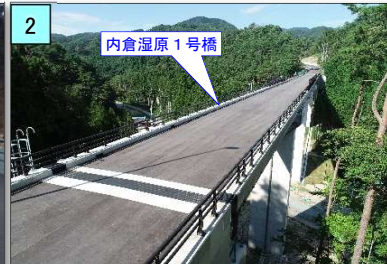
内倉湿原1号橋の完成状況
