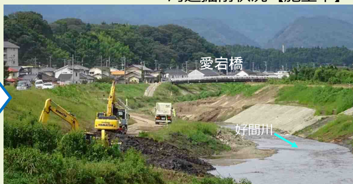
河道掘削状況【施工中】
