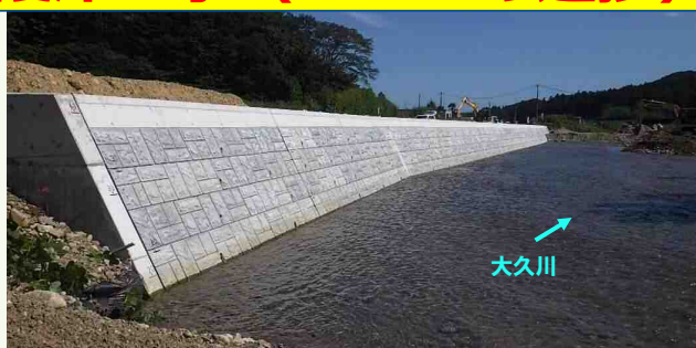
助塚工区の護岸工事を実施しています。
