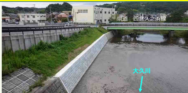
後三松工区の護岸工事が完了しました。
