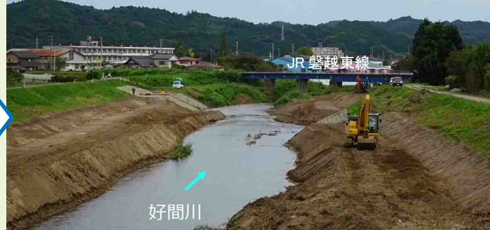
河道掘削状況【施工中】
