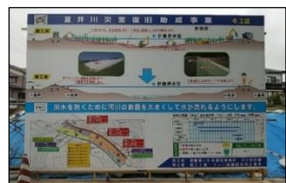
現場に設置した工事進捗看板
