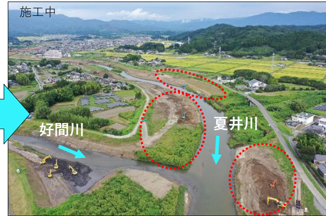
災害復旧助成事業により進む河川の伐木・掘削工事の状況
