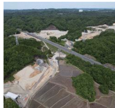
小名浜道路 常磐道付近
