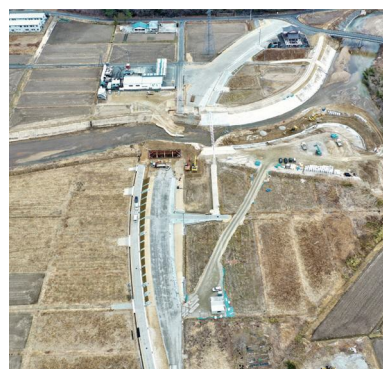
県道小野富岡線の整備状況
