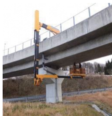
橋梁点検（あぶくま高原道路）
