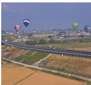
会津縦貫北道路の様子
