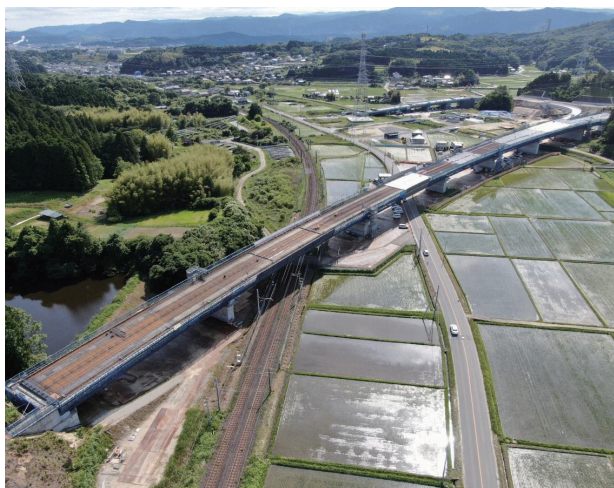
ふくしま復興再生道路（小名浜道路）
