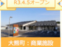
大熊町：商業施設
