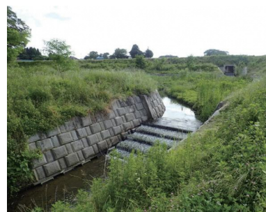
環境配慮型水路
