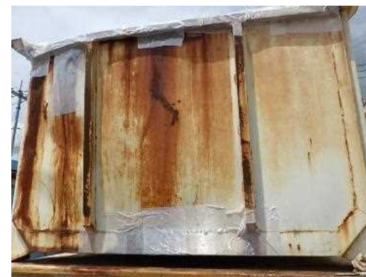
写真6.養生テープで補修後の写真5のコンテナ (5月26日実施・撮影)
