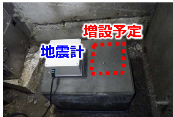
① 1階レベル (北西側構台下)
