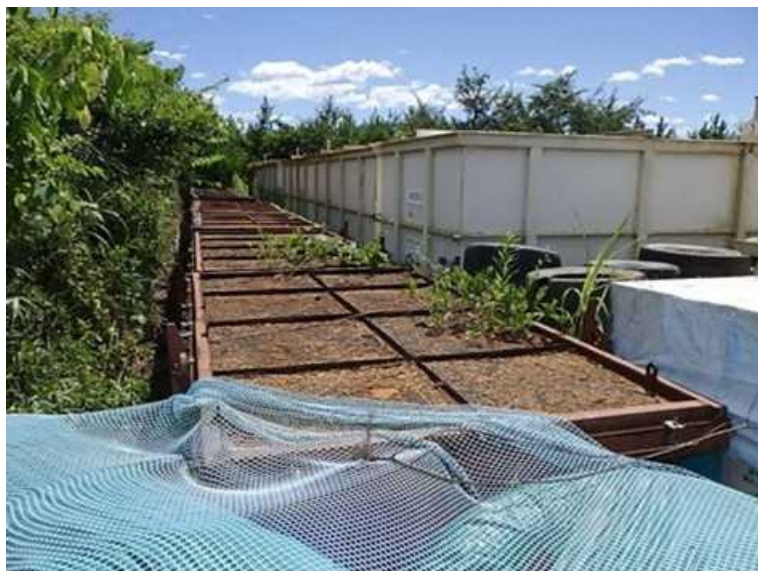
シート養生前
