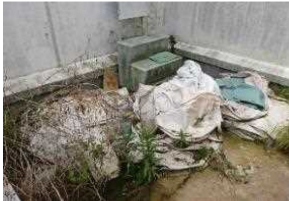
写真7. 4号機タービン建屋東側高線量物品 (5月14日撮影)
