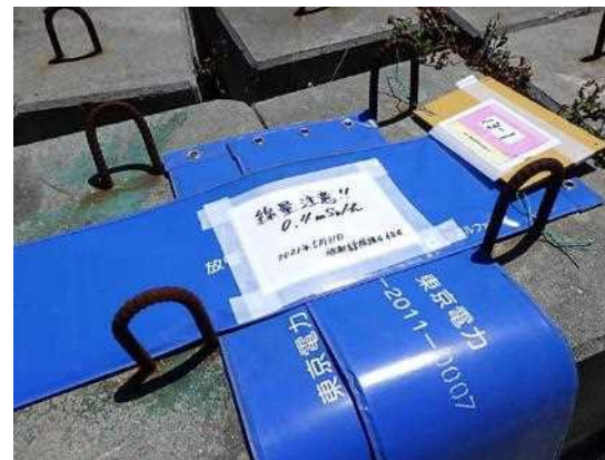
写真10. 線量率表記・遮蔽・区画後の写真9の物品 (5月26日線量率表記を実施、5月31日遮蔽・区画を実施・撮影)
