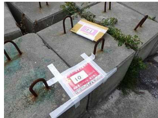
写真9. 1・2号機開閉所周辺高線量物品 (5月26日撮影)
