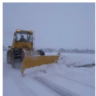
除雪作業状況
