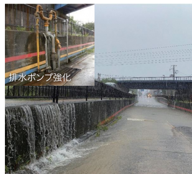
排水ポンプ強化 勿来浅川線大島ガード
