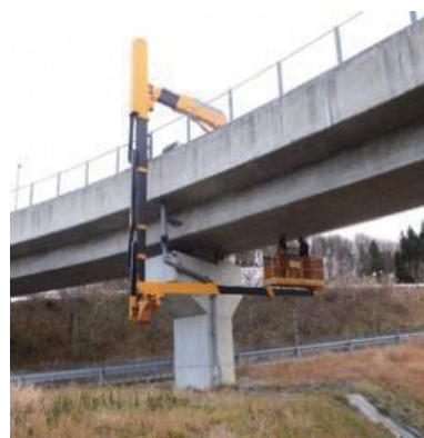
橋梁点検(あぶくま高原道路)
