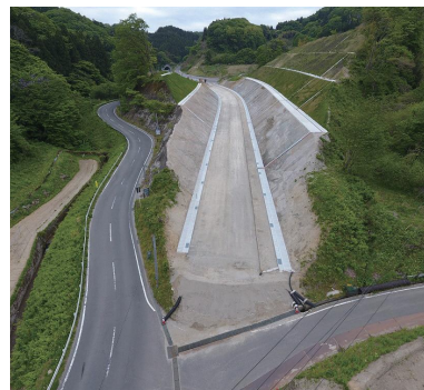
ふくしま復興再生道路(国道349号)
