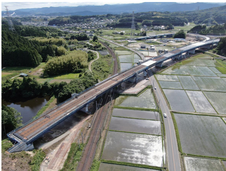
ふくしま復興再生道路（小名浜道路）
