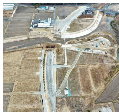
県道小野富岡線の整備状況
