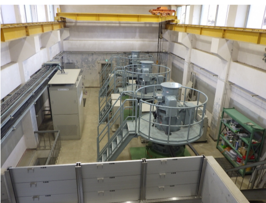
白沢揚水機場復旧後
