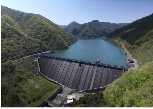
新宮川ダム(ドローンによる撮影)
