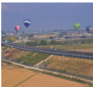
会津縦貫北道路の様子
