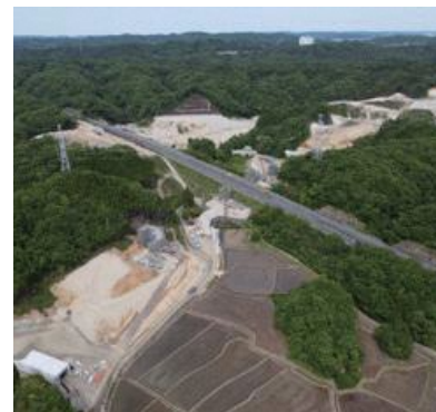
小名浜道路 常磐道付近
