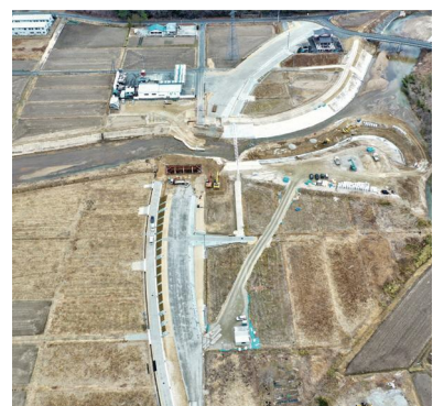
県道小野富岡線の整備状況
