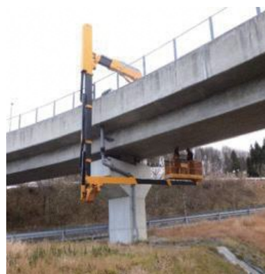
橋梁点検（あぶくま高原道路）
