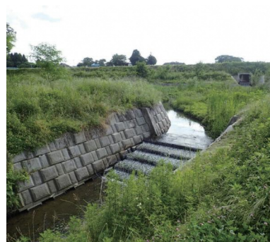
環境配慮型水路
