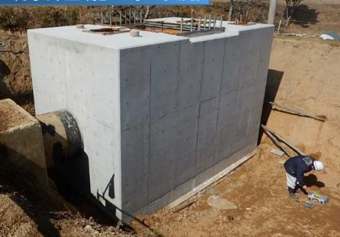
制水弁室(施工時の状況)
