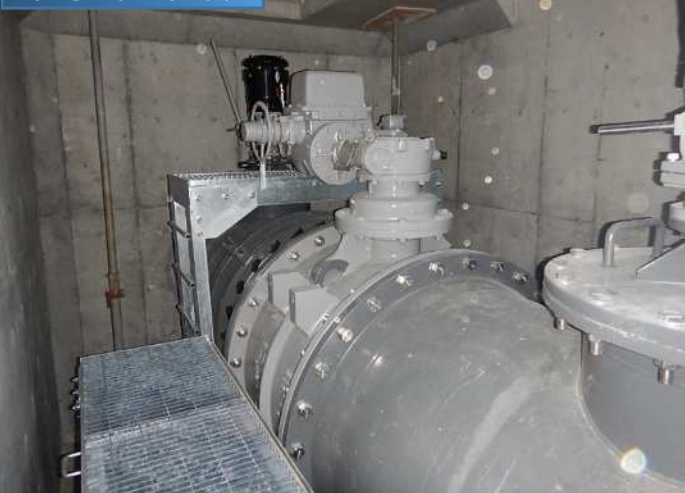
制水弁室内部
