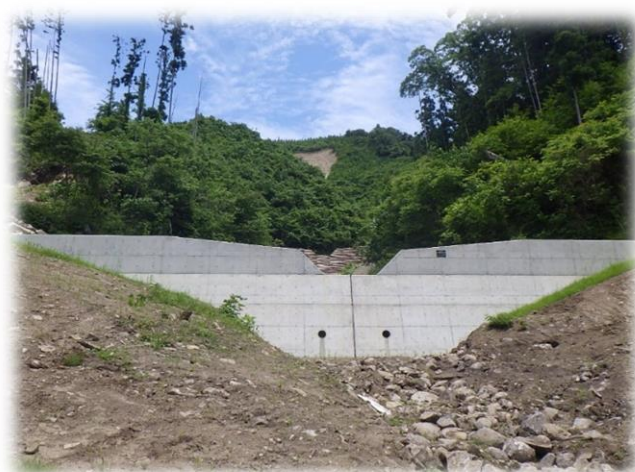
(完成した治山ダム)
