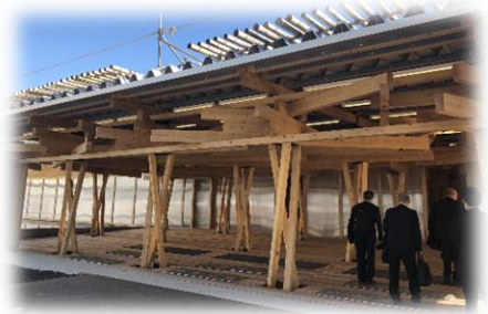
(選手村ビレッジプラザ・正面エントランス)
