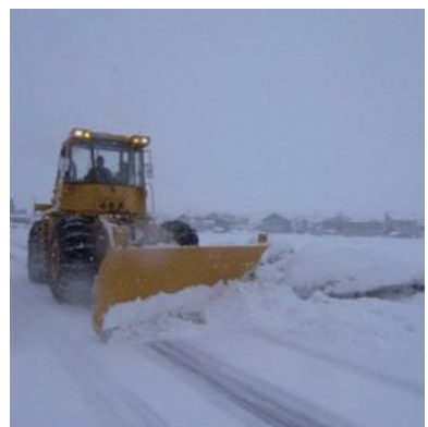
除雪作業状況
