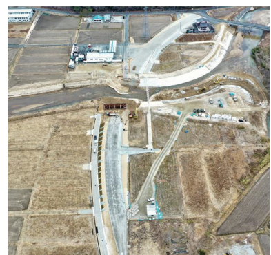
県道小野富岡線の整備状況
