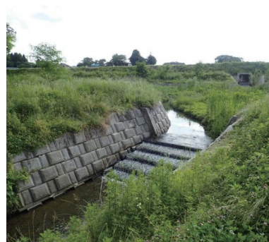
環境配慮型水路
