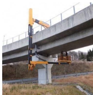
橋梁点検（あぶくま高原道路）
