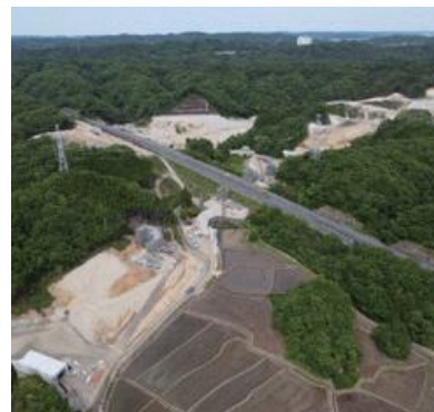
小名浜道路 常磐道付近
