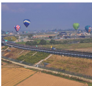
会津縦貫北道路の様子
