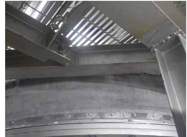
復旧・対策後の伸縮継手 （仮設灰処理施設その1）
