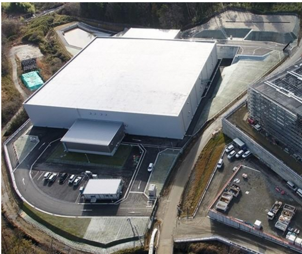
廃棄物貯蔵施設の外観
