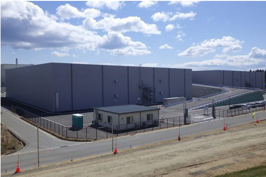
廃棄物貯蔵施設の外観
