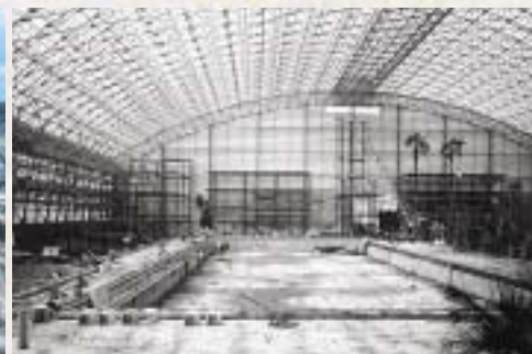
中央に柱がない工法でドームが建設され、当時としては画期的な、巨大な室内スペースが生み出されました
