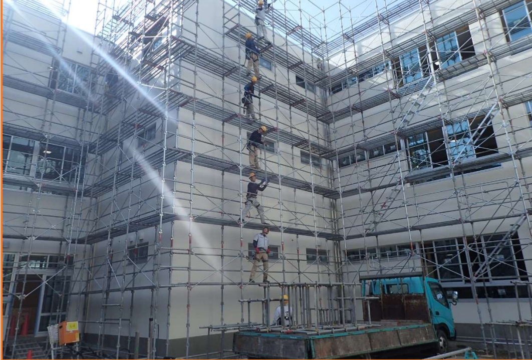
最優秀賞「連携（外部足場解体）」
