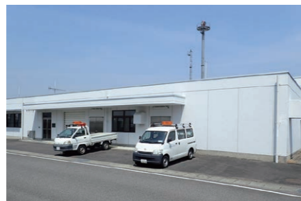
電源局舎 航空灯火に給電するための電源設備を収容する建物で、停電時に給電可能な発電機等も装備しています。
