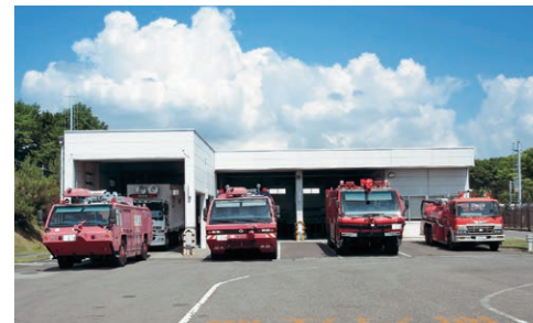
消防車庫 航空機に事故・火災が発生したとき、これを消火する車輛を格納しておく建物で、大型化学消防車(12,500ℓ1台)(10,500ℓ1台)(6,100ℓ1台)と給水車(8,000ℓ1台)、医療用搬送車(1台)を配備しています。
