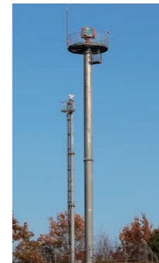
飛行場灯台 (ABN) 飛行中の航空機に飛行場の位置を示すための灯火です。
