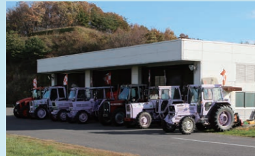
資器材倉庫 草刈機などの倉庫です。
