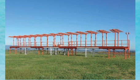
ローライザー (LOC) 着陸のため進入中の航空機に対して滑走路中心の左右のずれを電波によって示す装置です。
