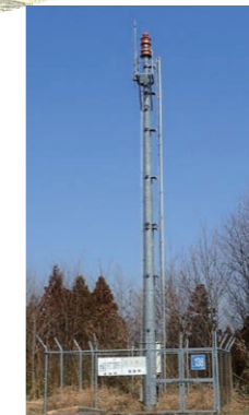
航空障害灯 (OBL) 水平表面から突出している地形の位置を示すための灯火です。(場外)
