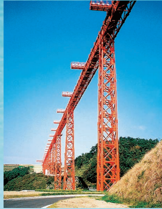
標準式進入灯 (PALS) 精密進入によって着陸しようとする航空機に、その最終進入の経路を示すための灯火です。L=780m
