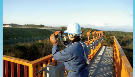
航空灯火の点検
