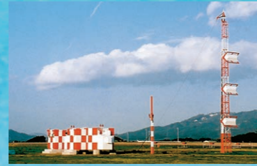
グライドスロープ (GS) 着陸のため進入中の航空機に対し適切な進入角を電波によって示す装置です。
