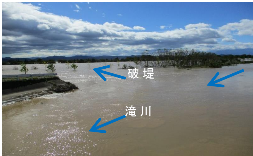
破堤部状況(欠下橋から撮影)
