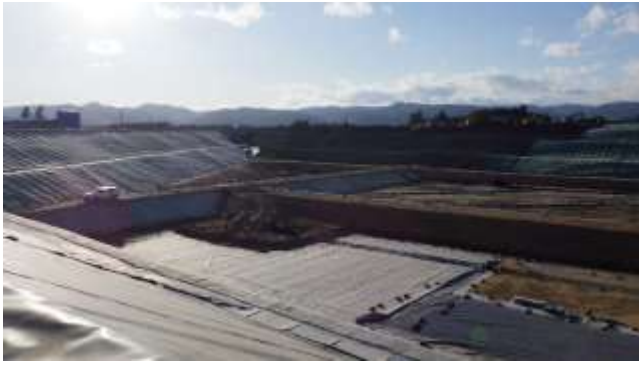
土壤貯蔵施設の埋立状況の確認
