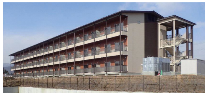
写真: 福島県 土木部より提供
