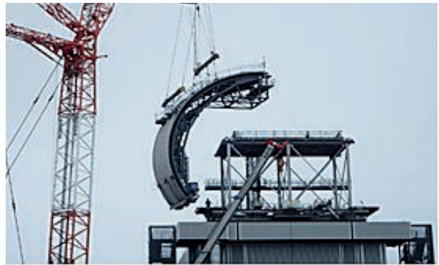
3号機燃料取り出し用カバー設置
