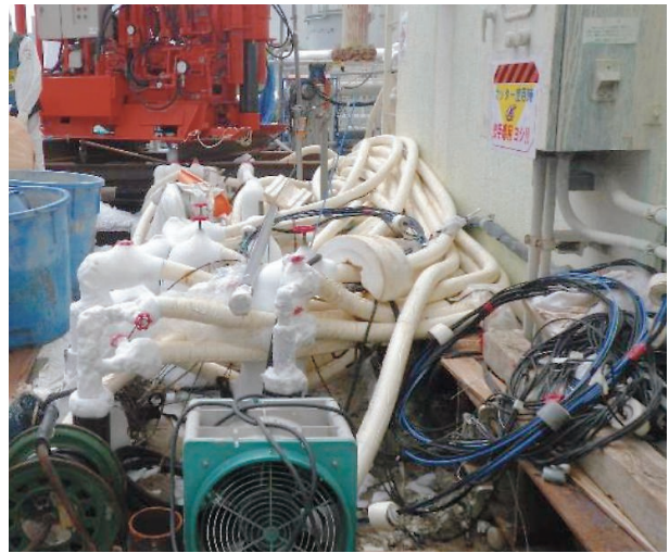
2号機海水配管トレンチ止水工事状況
