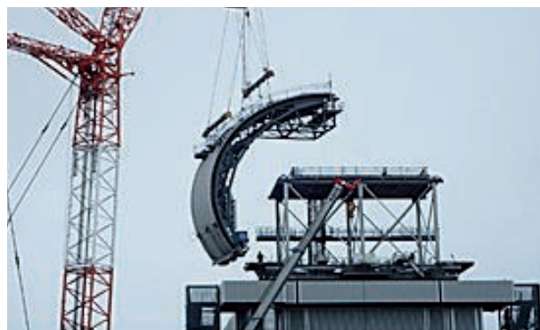
3号機燃料取り出し用カバー設置
