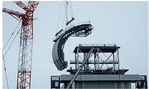
3号機燃料取り出し用カバー設置
