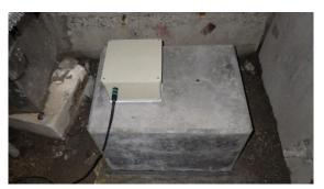
(写真1-3) 1階地震計の設置状況③ (今回(4月7日)撮影)
