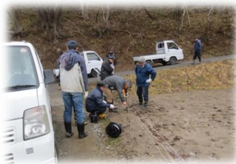
【管内における電気柵設置の様子】
