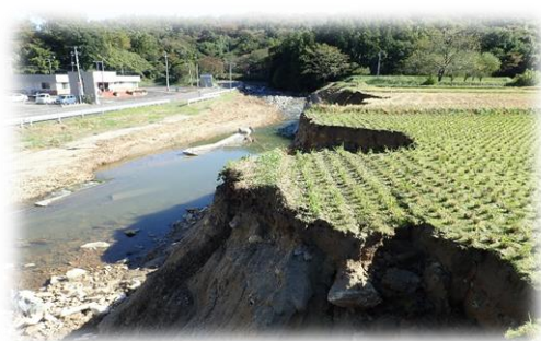
【畦畔及び用水路が崩落した水田】 (三春町)
