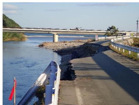
図 2 台風による洪水で崩落した道路
