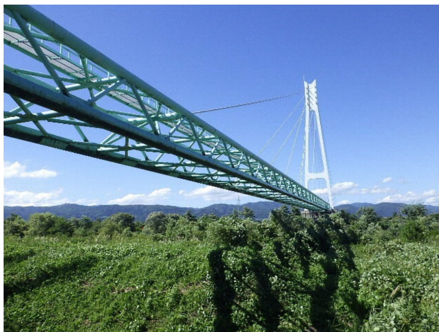
水管橋 写真提供：福島地方水道用水供給企業団
