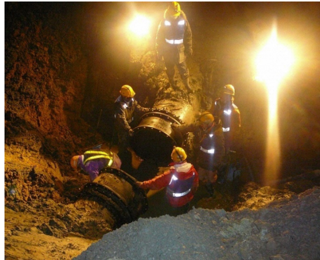
普段目にする事のない工事の様子 (昼夜を問わず行われた東日本大震災の復旧工事) 写真提供：いわき市
