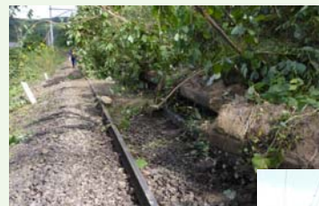
▲ 被災直後 (令和元年10月)
