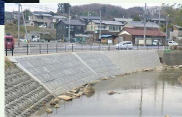
▼ 復旧後 (令和2年3月)
