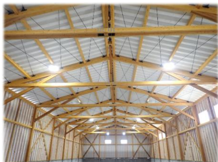
(木造倉庫の内部)
