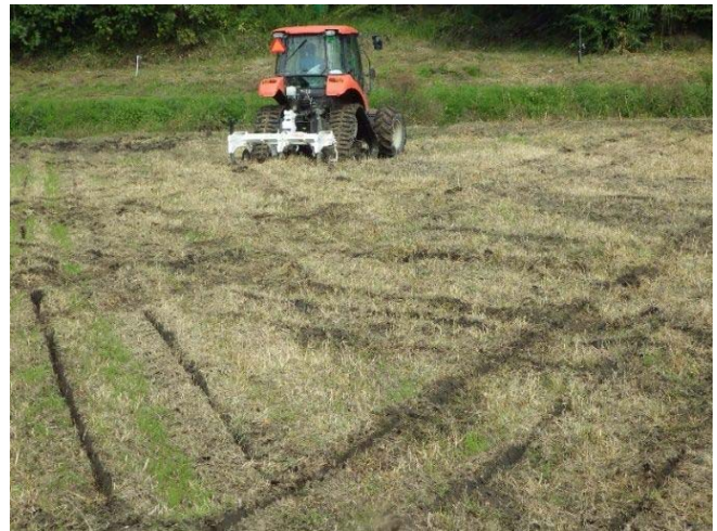
図2 サブソイラによる補助暗渠設置
