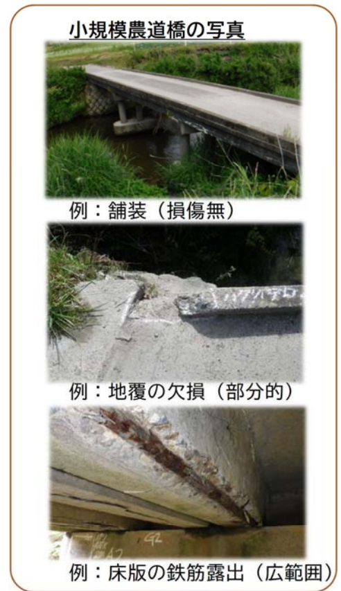
図2 点検箇所の状況例
