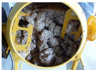
①コンクリートミキサーによる混合
