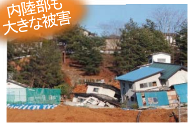
家屋被害の状況（福島市伏拝地内）
