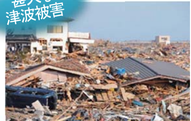
家屋被害の状況（浪江町請戸地区）
