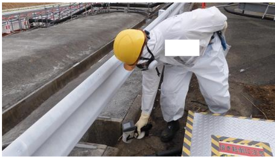
(写真7) 堰外近くの側溝 この先で物揚場排水路に合流している
