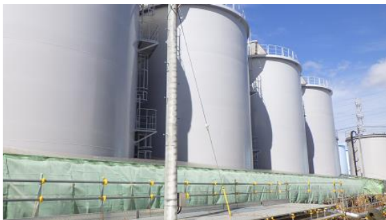
(写真1) Dタンクエリア外観 (南側から撮影)
