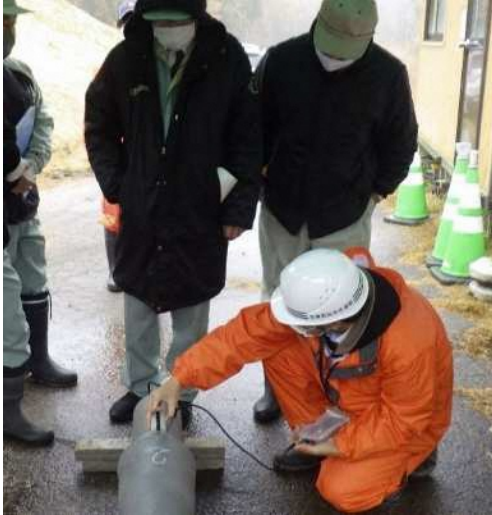
管路の継手部分のチェックについて 市議会議員に説明する職員 写真提供：会津若松市
