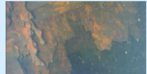
ペDESTAL内側の状況※3
