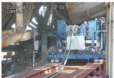
支保台車設定完了
