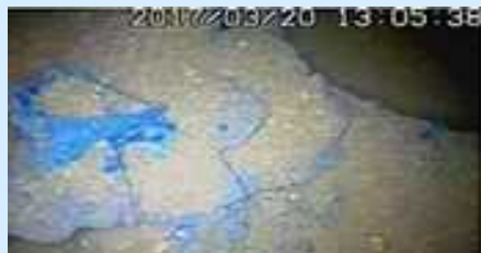
ペDESTAL外側の状況※3
