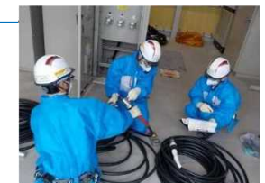
ケーブル導通訓練
