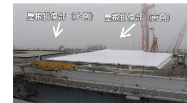
屋根状況【流入防止堰・雨水カバー（南側） 設置完了】〔西側から撮影〕
