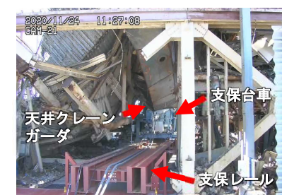
④天井クレーン支保設置作業完了後の状況
