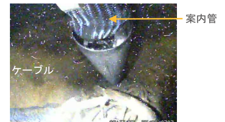
④ケーブルの状況
