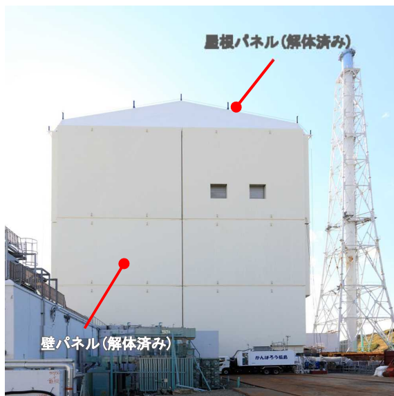
建屋カバー竣工時 (撮影：2011. 10)
