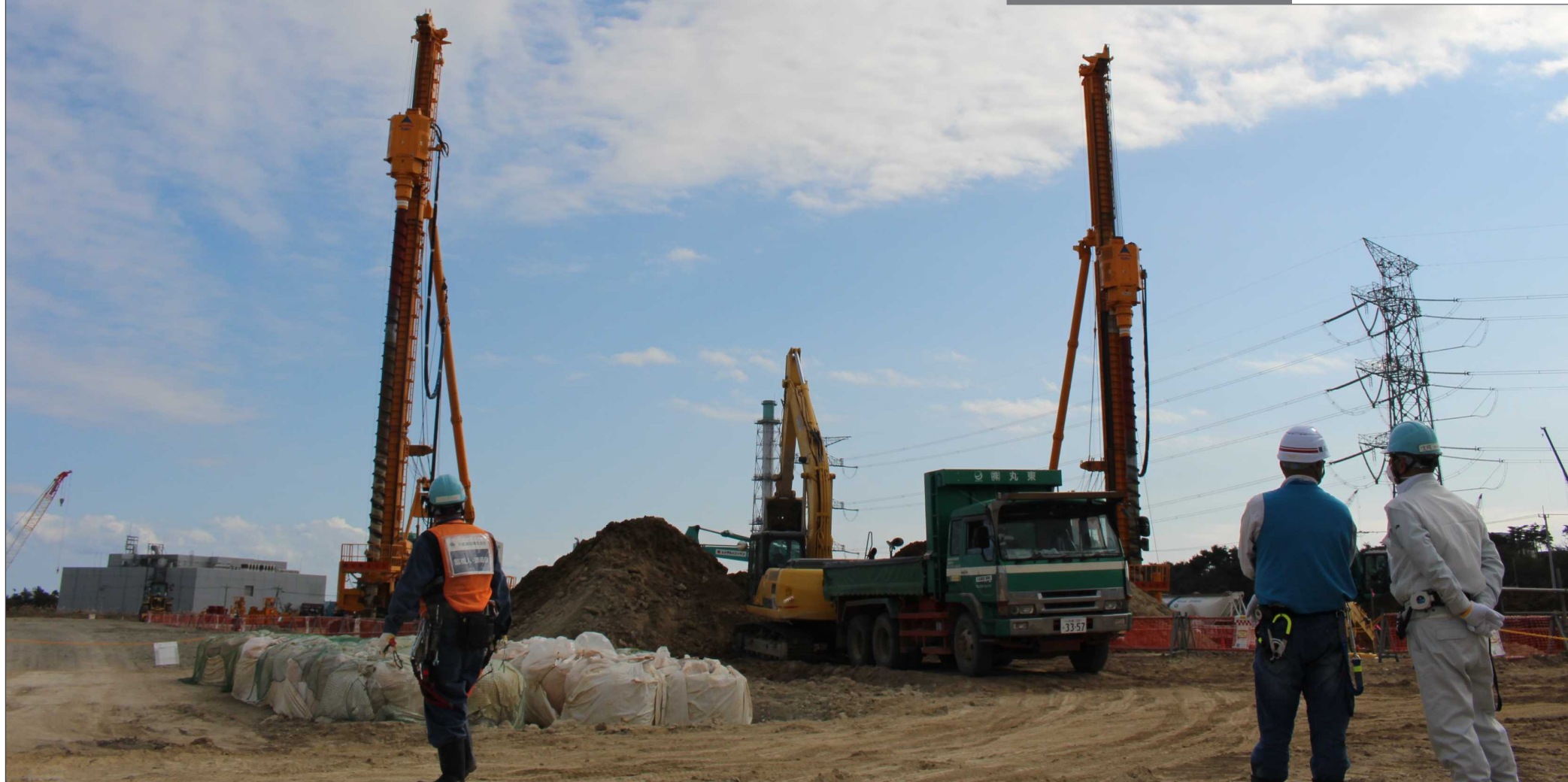
廃棄物関連施設の地盤掘削の様子
