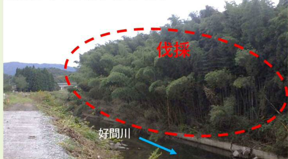
①好間町下好間字羽竜地内 【施工前】
