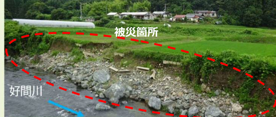
②好間町北好間字寺入地内 【施工前】
