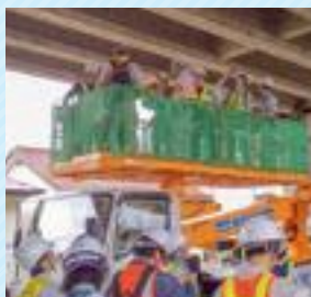
橋梁点検の実習
