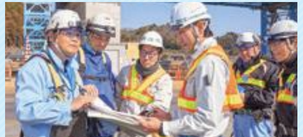
工事が工程どおり進んでいるか現場確認
