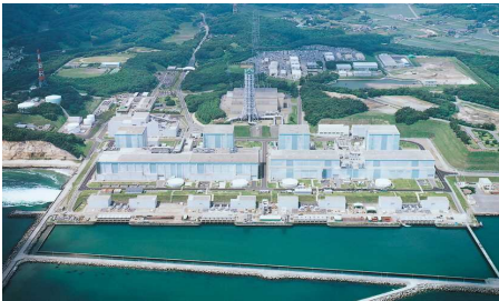
福島第二原子力発電所
