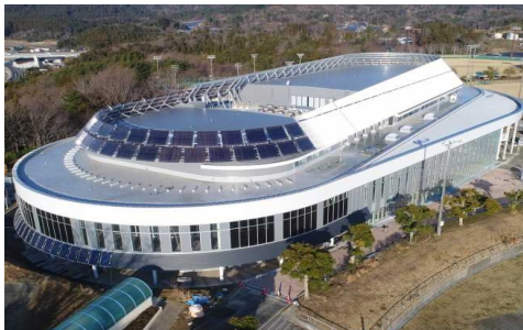
ならはスカイアリーナ 屋上や敷地内で太陽光発電。
