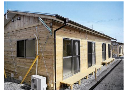
③住戸に縁側を設置
