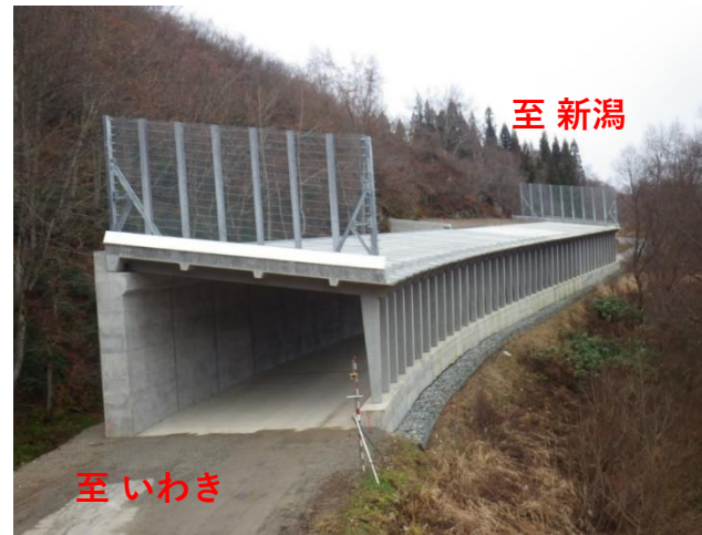
スノーシェッド 工事状況
